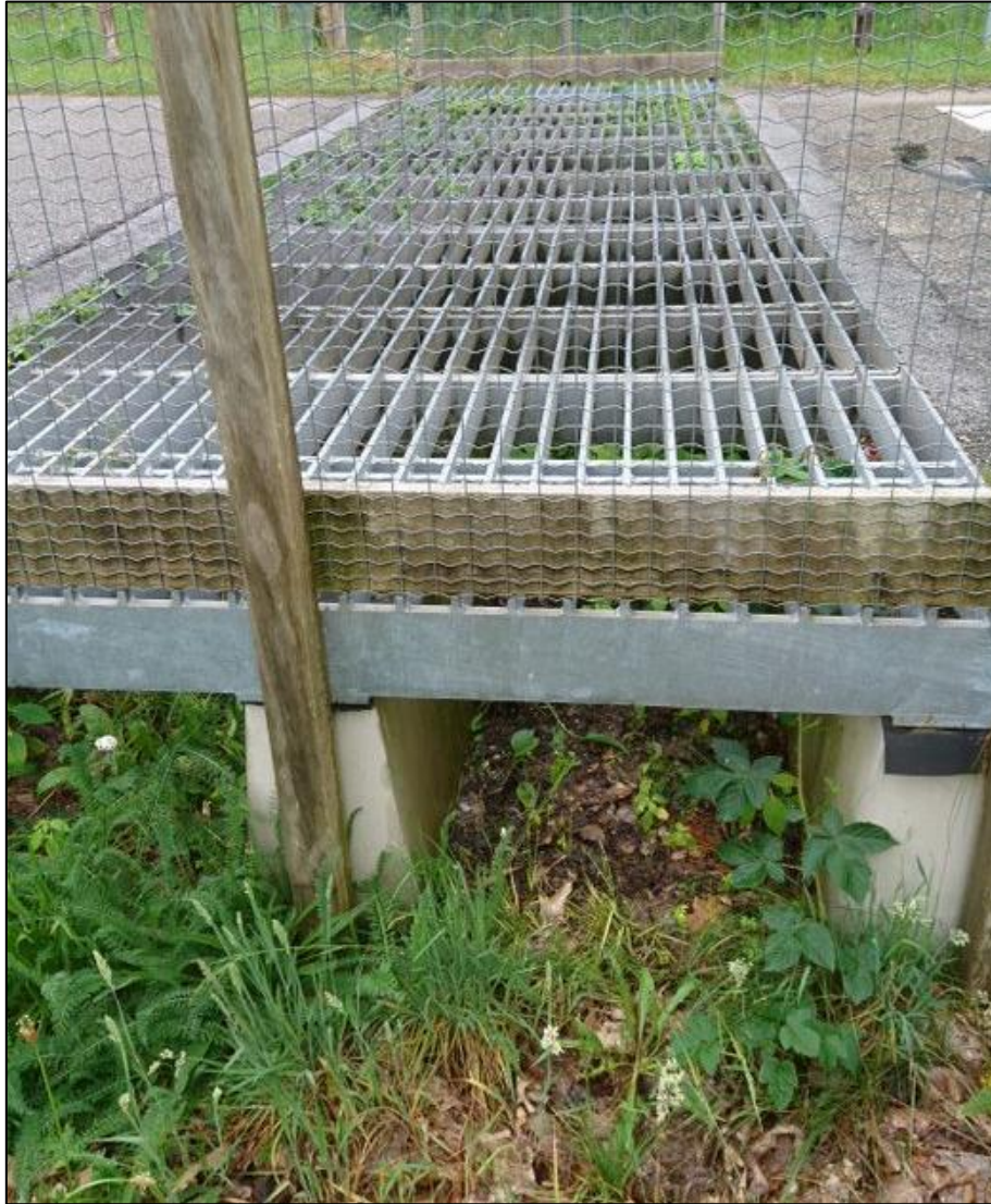
Figuur 7.2 Een faunapassage die geschikt is voor egel. Bron: Ecogroen.
